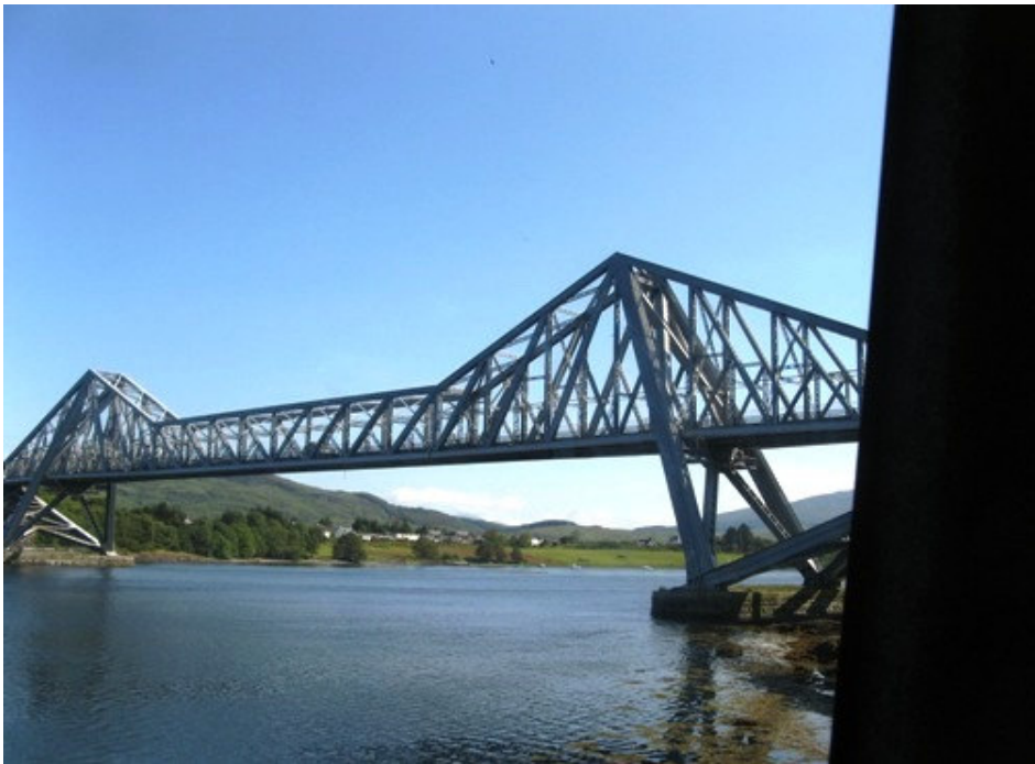
Connel Bridge: Øst for Oban (ad A 85) så vi den imponerende Connel Bridge med et flot spænd over fjorden Firth of Lorne. Spændet over fjorden er løst som en gitterbro af stålbjælker med de 2 knudepunkter udført som Gerberkonstruktion. På landsiderne er broen opført som en buebro (viadukt) af granitsten med 3 høje romanske buer på hver side. Er bare så flot.
