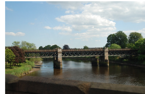
Stirling jernbanebro over River Forth. Er opført som bjælkebro med gitterkonstruktion af stålbjælker på granitbårne bropiller i 1800-tallet. (Brotypen kaldes også gitterbro)
