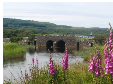
Broen over floden Bellart ved den gamle by Dervaig mellem Calnary og Tobermory. Granitbroen er udført som buebro med 2 "normale" buer samt flere små rektangulære sideåbninger til brug ved højvande.
