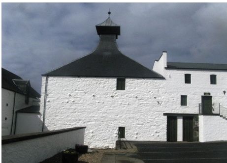
Destilleriet Ardbeg. Skorstenen udført som pagodetag placeret over tørreloftet
